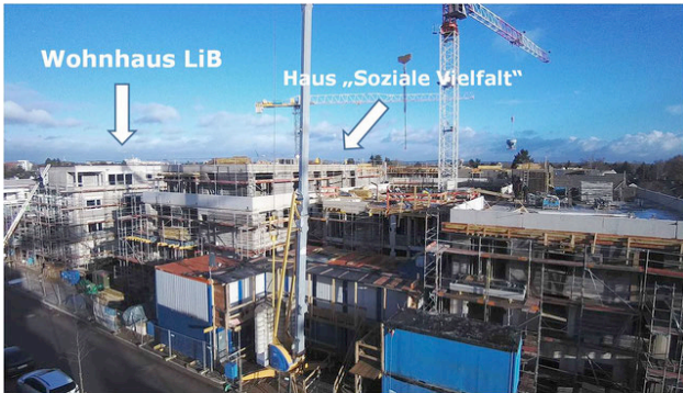
Die Baustelle in Köln-Ostheim
